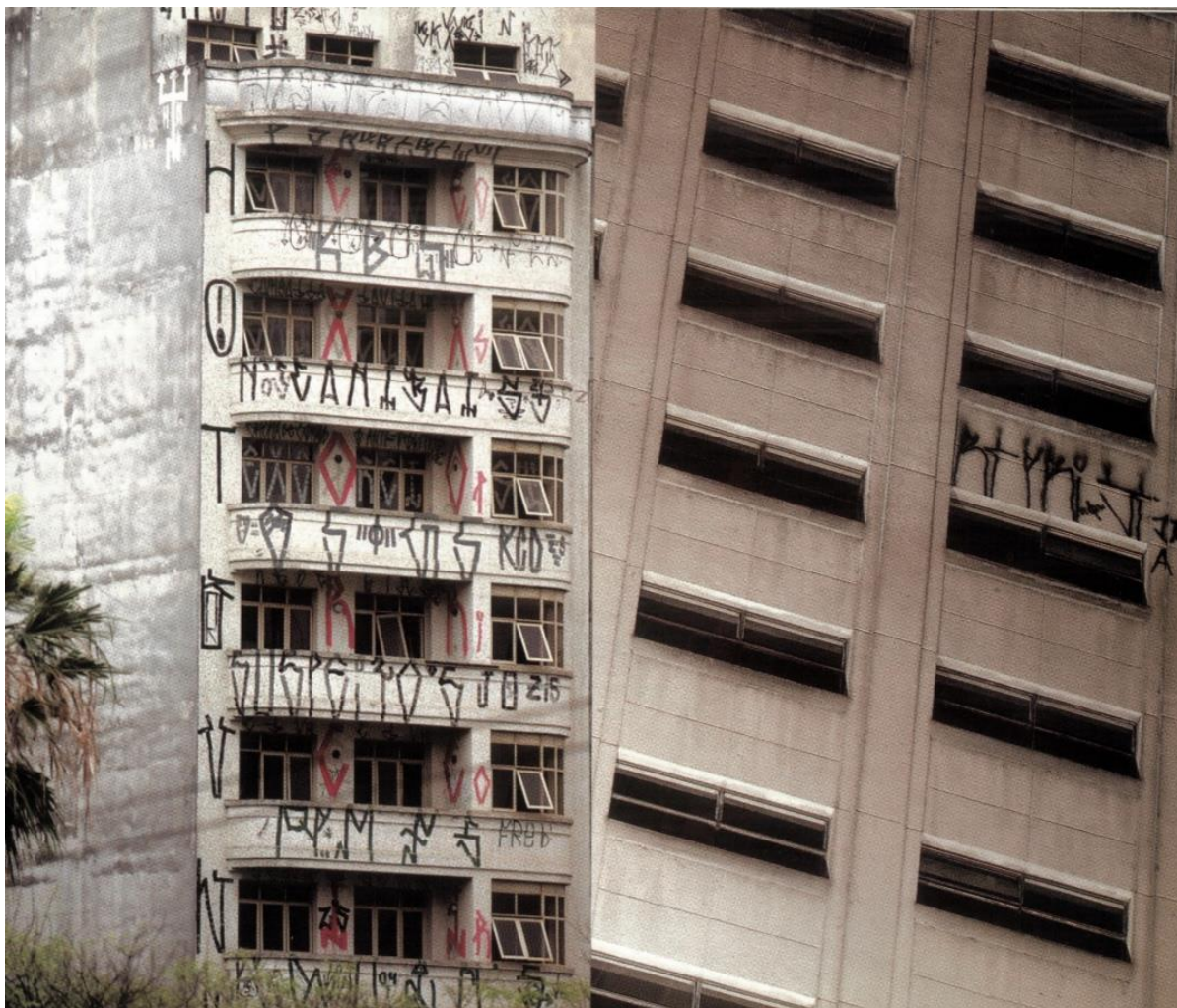
Figura 4. Registro da pixação na cidade de São Paulo. Foto tirada da obra Ttsss... a grande arte da pixação em São Paulo, Brazil .
